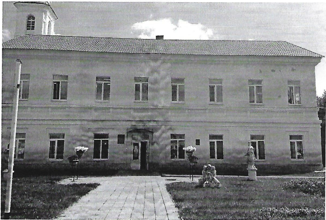
Здание районной библиотеки г. Фокии пл. Октябрьской д 4
